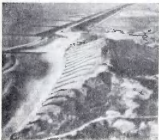
Рис. 1. Дюны на западном побережье Нидерландов. На заднем плане — дамба с бунами, защищающая польдер
